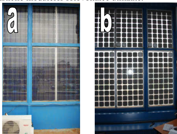
Fig. 7.2: Instalația fotovoltaică (PV) văzută din (a) exterior, (b) interior
